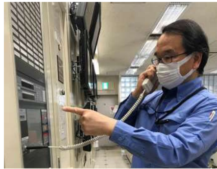
③ 防災センターにつながる
