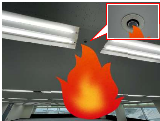
② 感熱部可溶片が溶ける
